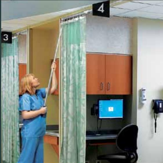
**Paso 2** Coloque una cortina limpia en el portador. Con la varilla Qwik Switch, empuje el riel hacia el cielo raso y la unidad de cierre Qwik Switch asegurará el riel en su posición.
