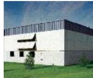
*Es posible que los paneles de venteo de explosión que dependen de una instalación adecuada en el campo no funcionen. Sin embargo, Explovent, que es comprobable y reajutable, está calibrado en la fábrica para una liberación a presiones muy bajas.*
