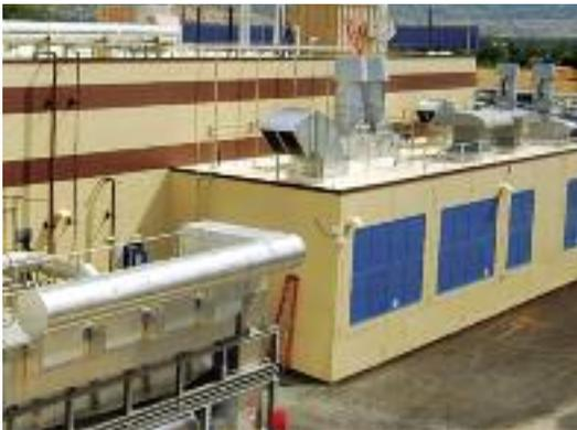
*Se usa gas etileno para esterilizar los equipos médicos en la sala de almacenamiento de la instalación. Los paneles Explovent fueron especificados para liberar la acumulación de presión del gas, en caso de que sea necesario.*
