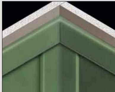
**Esquina interior de altura parcial (10mm o 3/8" de grosor)** Incluye guarnición horizontal de 13mm (1/2") de grosor
